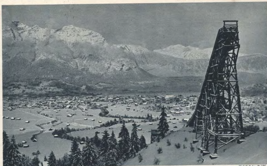
Olympia-Laufschanze mit 44 m hohem Anlaufsturm. Blick auf Garmisch-Partenkirchen
