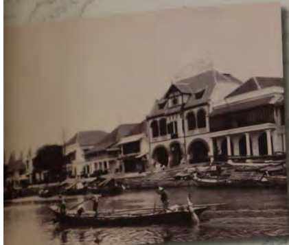
Kantoor van 'De Algemeene' in Soerabaja, ontworpen door Berlage. Collectie KITLV, Leiden
